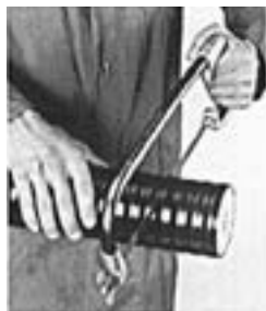
1 Rohr richten und rechtwinklig ablängen.
