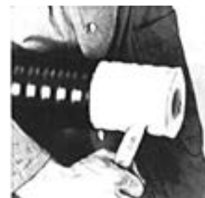
7 Dämmung über die Länge X, (Z) zurück schneiden/entfernen. Achtung: PEX-Rohr mit EVOH-Sperre!
